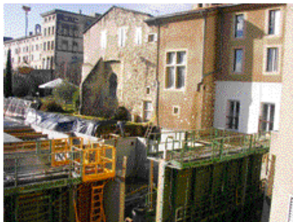
Le chantier du futur hôpital a déjà démarré
